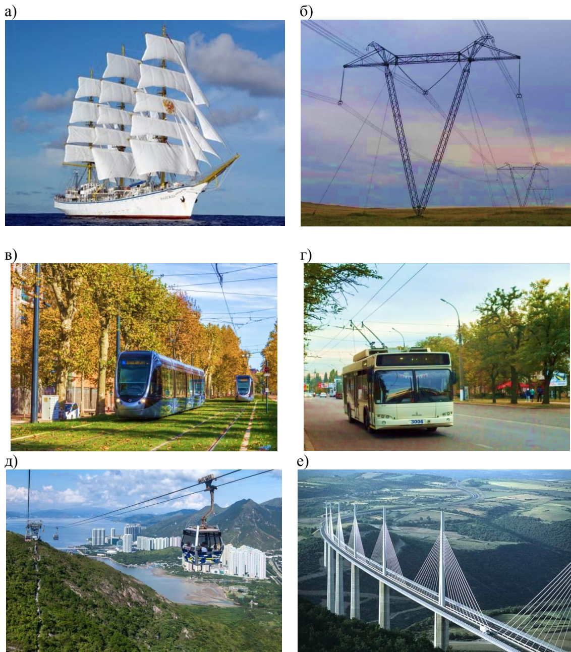
Рис. 1. Использование вант в виде оттяжек в разных сферах деятельности человека: а) парусное судно; б) высоковольтные линии электропередач; в) тросы контактной сети трамвайных линий; г) тросы контактной сети троллейбусных линий; д) канатная дорога; е) вантовый мост Fig. 1. The use of stay cables in the form of guys in different fields of human activity: a) sailing ship; b) high-voltage power lines; c) cables of a tram line catenary; d) cables of the trolleybus line catenary; e) aerial railway; e) cable-stayed bridge
