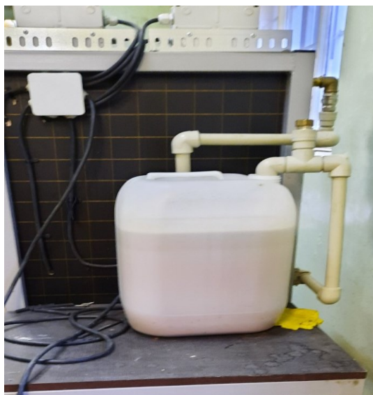
Рисунок 2.3 – Емкость с водой и трубопроводами
