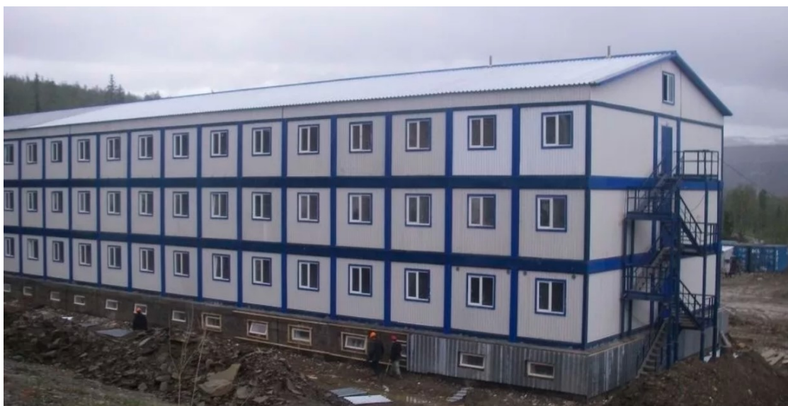
Рисунок 4.7 – 3-этажное мобильное здание из контейнеров
